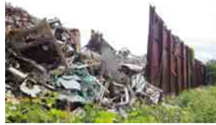
スクラップで崩壊した囲い
